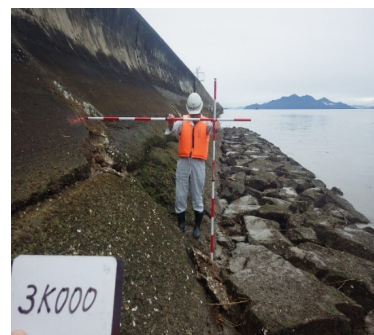
洪水痕跡調査状況
