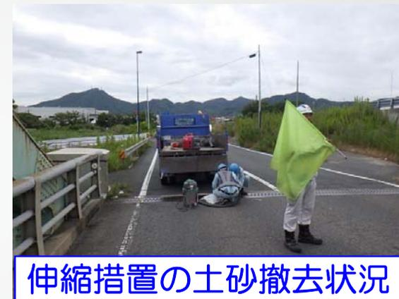
伸縮措置の土砂撤去状況
