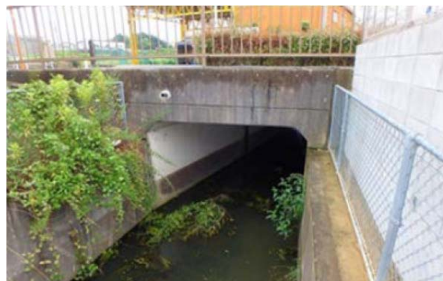
特定の溝橋 (常時水がある箇所)
