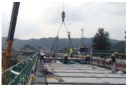
プレキャスト床版による 打ち替え
