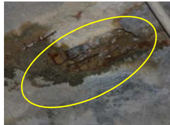
覆工コンクリートの剥落・貫通ひび割れ
