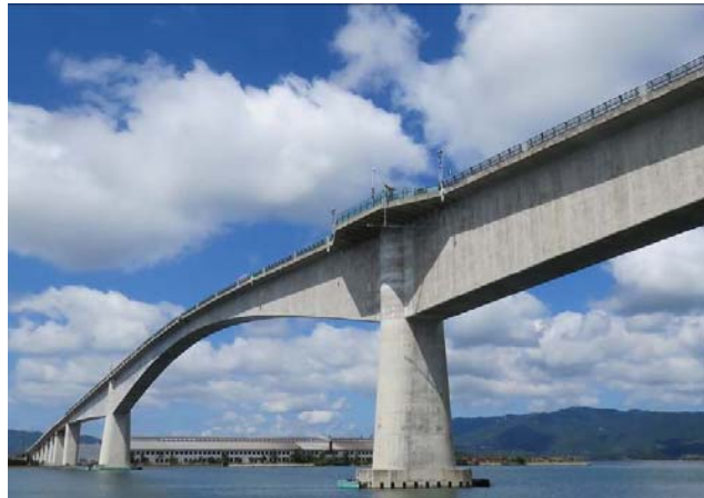
コンクリートが大部分の橋梁 (PC中空ラーメン橋等)
