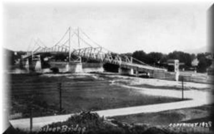
シルバーブリッジ（1928年完成）
