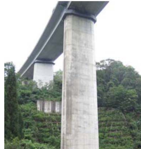
高さのある高架橋のコンクリート橋脚、橋台
