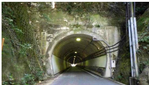
＜仁方隧道の状況＞
