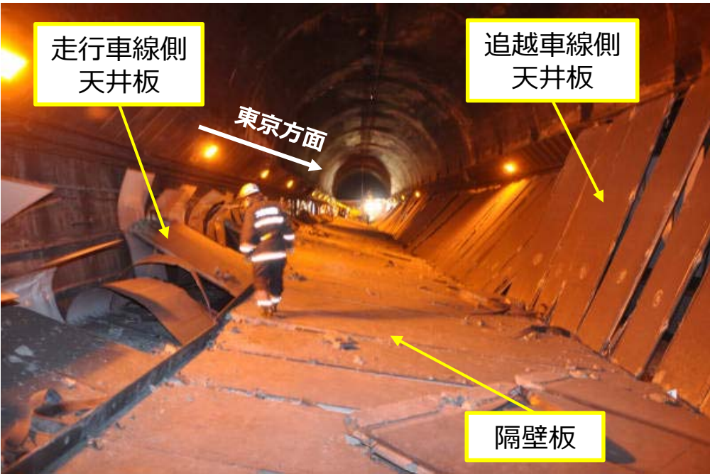
笹子トンネル（上り線）東京方面
