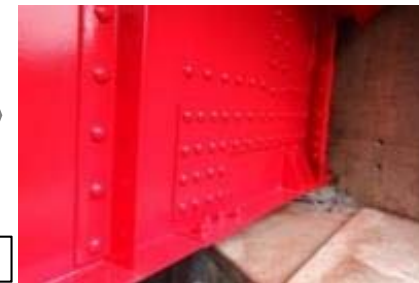
桁端部の当て板・塗装
