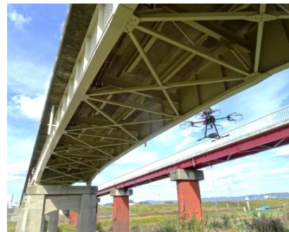
▲ 橋梁の損傷写真を撮影する技術
