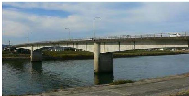
＜天大橋の状況＞
