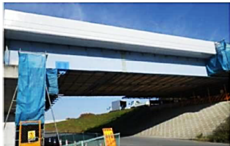
橋梁点検と補修工事で 足場を共有
