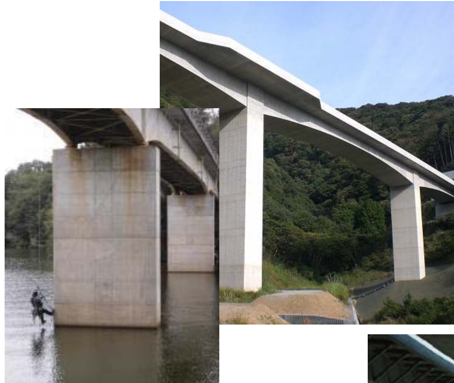
ロープアクセスが必要な橋脚
