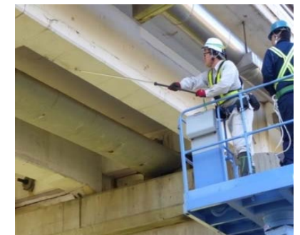
▲ コンクリートのうき・はく離を非破壊で検査する技術
