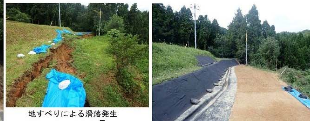
応急対策としての浸透防止工
