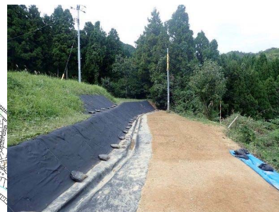
④ 浸透防止工(排水シート)
