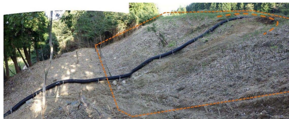
⑫ 既16ブロック 排土工(H14施工)
