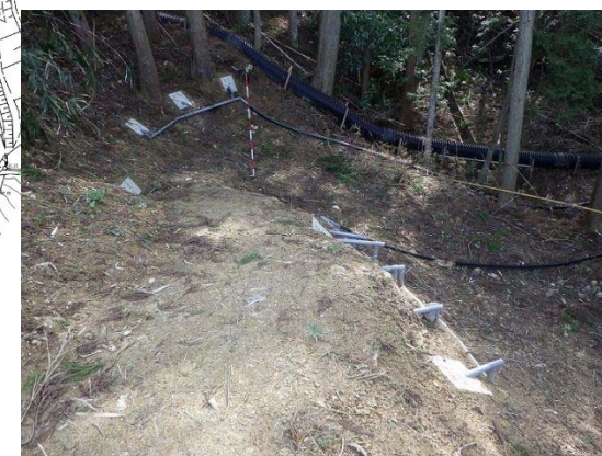
③ 応急水抜きボーリング工
