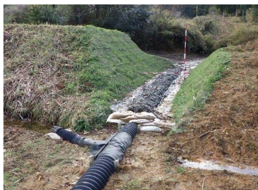
◎浸透防止工(ため池開削)
