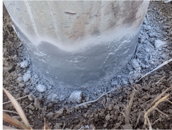
支柱基部 簡易補修
