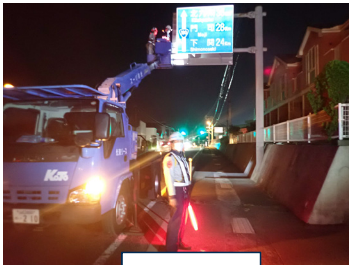
維持工事の 規制区間内 で点検作業
