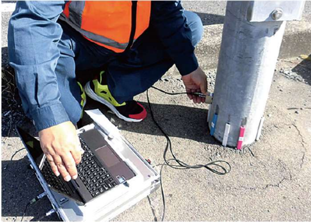
支柱基部点検
