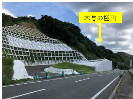
写真-1 工事用道路②起点側
