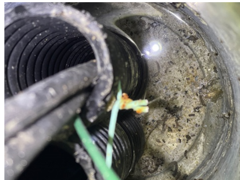
支柱内部の耐水
